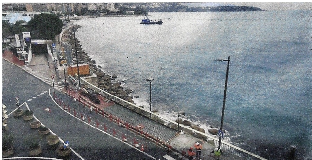
Dans l'anse maritime du Portier, une zone a été délimitée pour permettre le début des manœuvres. (Photos Cyril Doderan)
